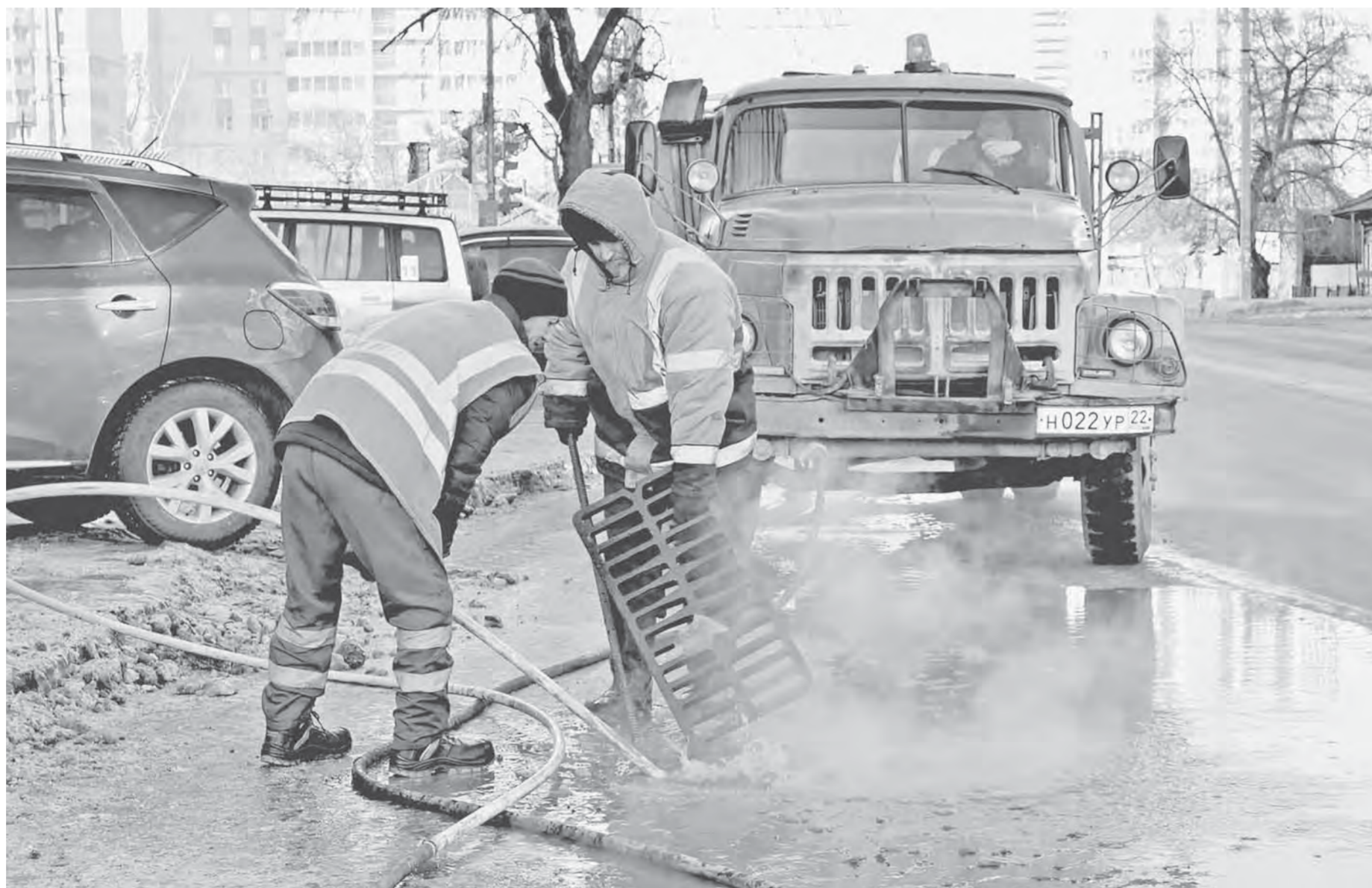
Рабочие МБУ «Автодорстрой» чистят ливневую канализацию от наледи и снега.
