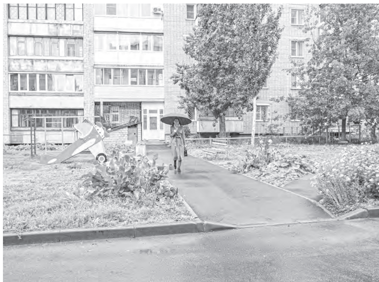
Этим летом работы по обновлению барнаульских дворов будут продолжены.
