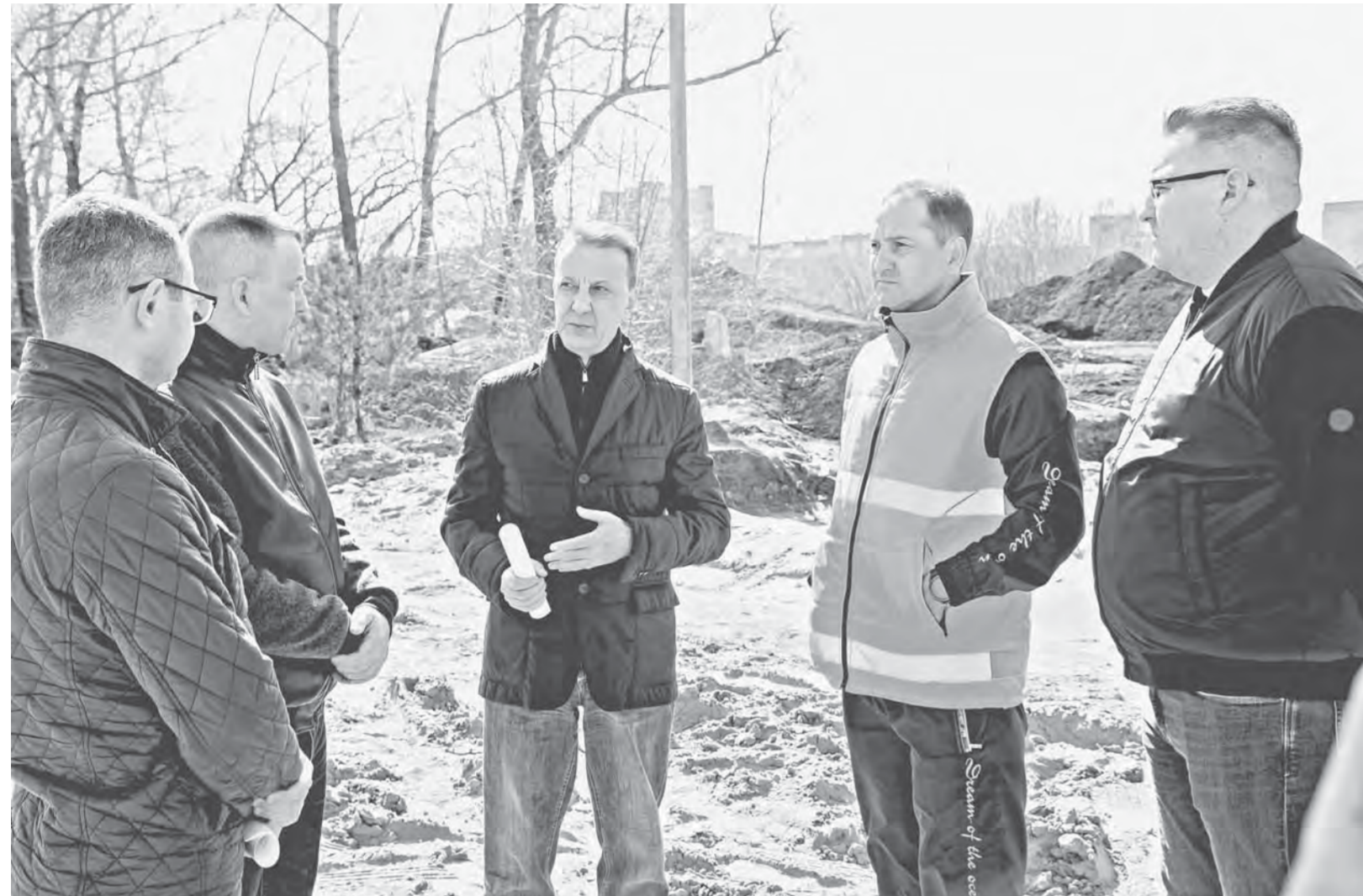
Вячеслав Франк проверил ход работ на строящемся дорожном участке.
